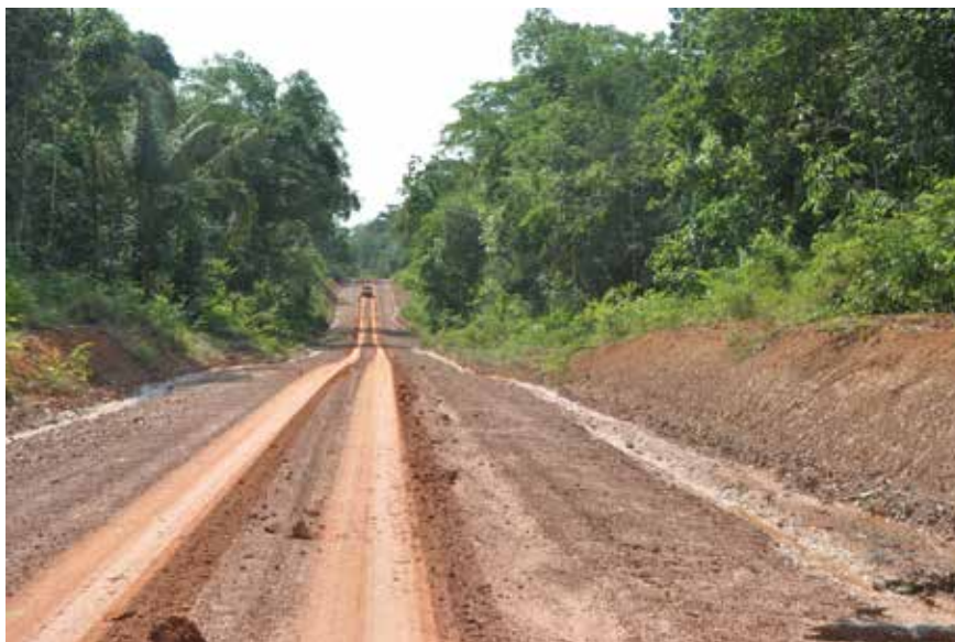
FIGURA 11 – Trecho recuperado da rodovia estadual AM-364 que liga a BR-319 ao Rio Madeira (foto tirada em outubro de 2017).
