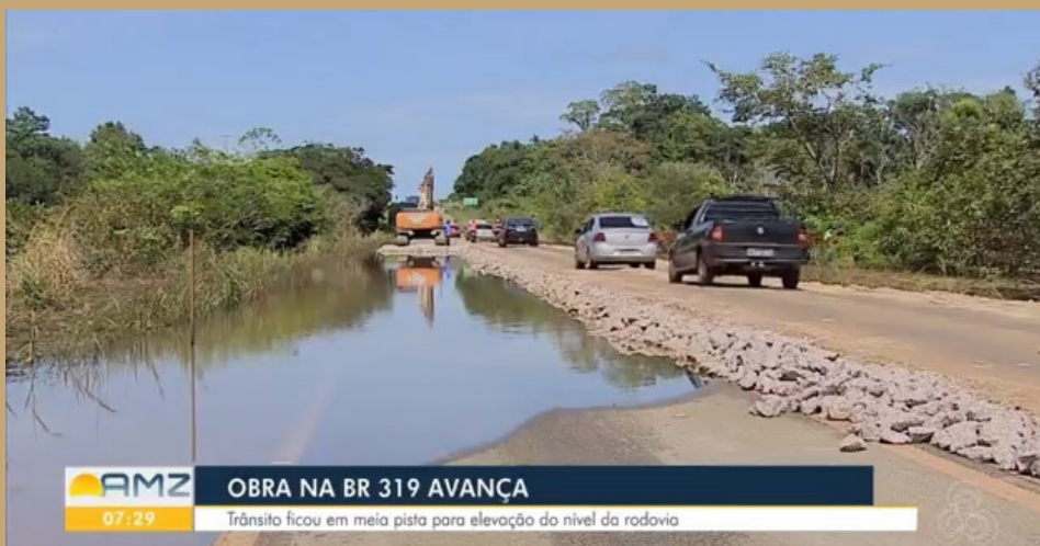
Trecho em obras da BR-319. Fonte: G1 Rondônia
